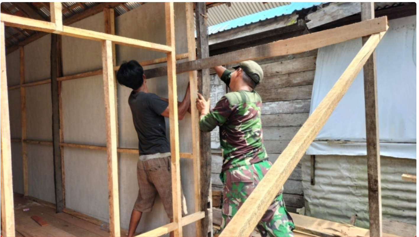
Pemasangan Dinding Rehab RTLH, Kodim 1002/HST
